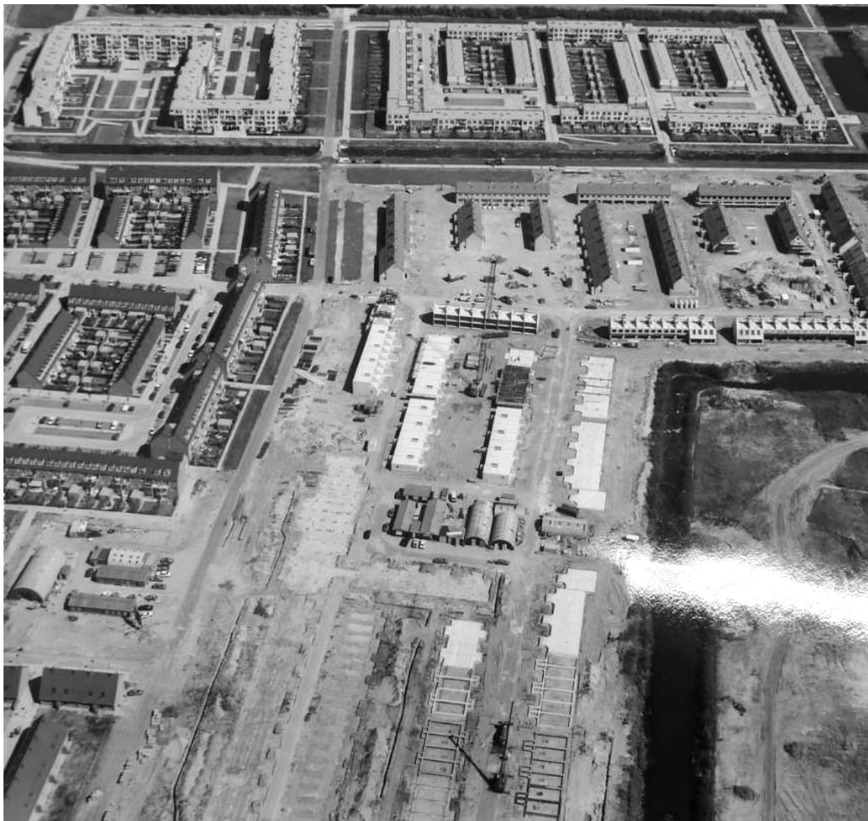
Afbeelding 119: Gein 4 vanuit het zuiden gezien. Op de voorgrond is het industriële en seriematige bouwproces van de lage bebouwing aan de zuidoosthoek te zien. Uit: Archief stadsdeel Zuidoost.
