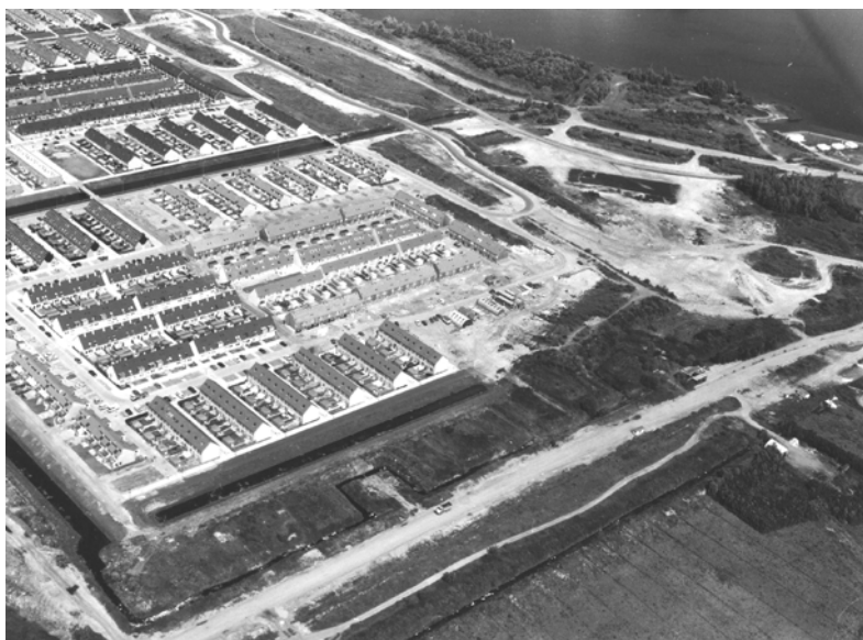
Afbeelding 122: Gein 3 vanuit het oosten gezien. Op de voorgrond zijn de oost-west stroken in aanbouw. Uit: SAA, B00000037635, 1987.
