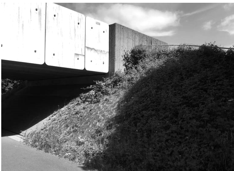
Afbeelding 6: Eenvoudige betonnen viaduct in Reigersbos. (Foto: MenA 2018).
